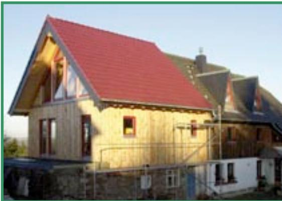
Holz ist leicht zu bearbeiten und öffnet mit den verschiedenen, schlanken Systembauweisen weite Gestaltungsspielräume. Bauteile aus Holz lassen sich daher gut in den Bestand einpassen, ohne z.B. die Statik des Hauses zu stark zu belasten: Dachausbauten, Grundrissumgestaltungen und somit neue Nutzungsmöglichkeiten können nahezu bei jedem Gebäude realisiert werden.
